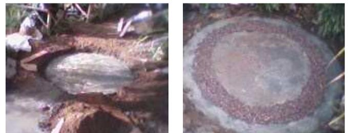
Gambar 4. Pembuatan Tutup Sumur Resapan Pengamatan pada saat masa pemeliharaan mendapatkan kesan bahwa masyarakat belum memanfaatkan secara maksimal kehadiran sumur resapan. Pada Gambar 5a terlihat bahwa masih terjadi genangan air di sekitar lokasi sumur resapan, yang dikaitkan tidak lancarnya air masuk ke dalam sumur. Sedangkan pada Gambar 5b terlihat jelas bahwa lubang saluran yang menuju ke lokasi sumur sudah tertutup, walaupun sumur baru berumur 3 bulan.
